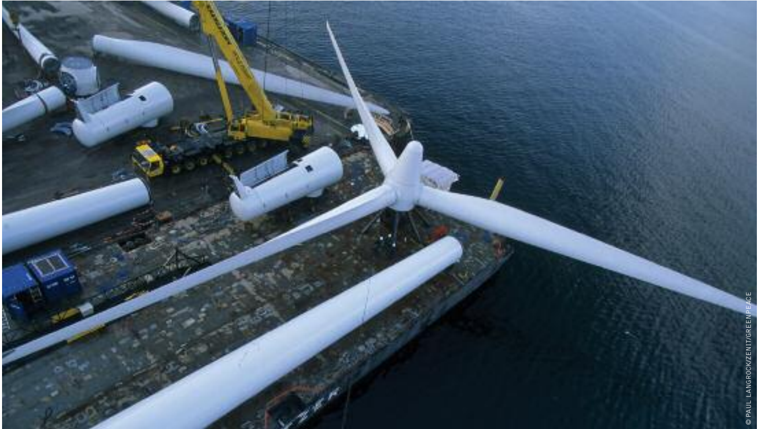
imagen CONSTRUCCION DE TURBINAS OFFSHORE EN MIDDELGRUNDEN CERCA DE COPENHAGUE, DINAMARCA
