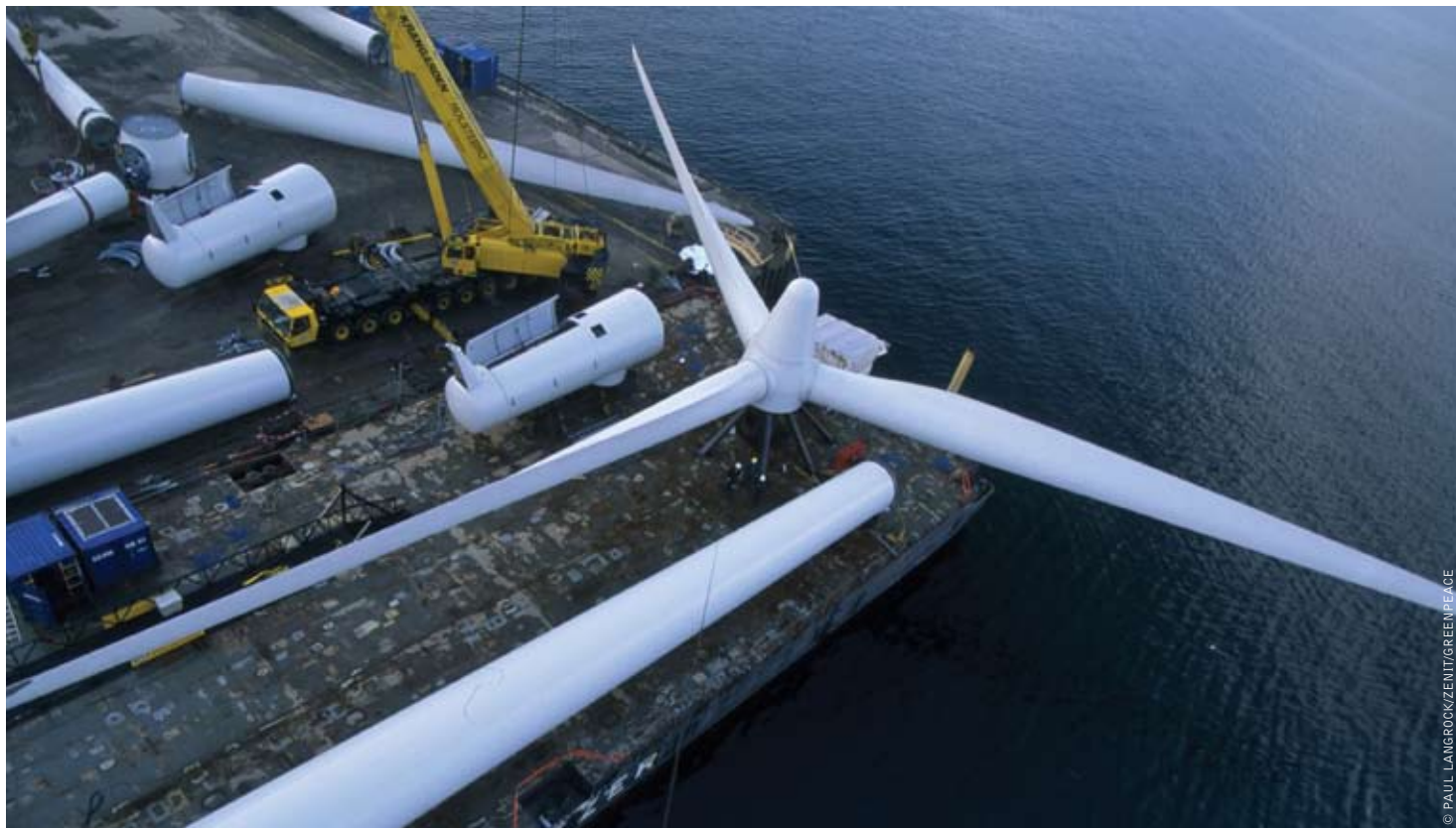
imagem CONSTRUÇÃO DE PARQUE EÓLICO OFFSHORE EM MIDDELGRUNDEN, PERTO DE COPENHAGEN, DINAMARCA.
