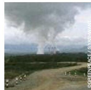
Columnas de humo procedentes del lignito quemado en la central térmica de Mae Moh, Lampang, provincia de Thailandia. Greenpeace y los ciudadanos del distrito tienen serias quejas respecto a la central insistiendo en que causa problemas respiratorios y lluvia ácida que daña la agricultura de los alrededores.
