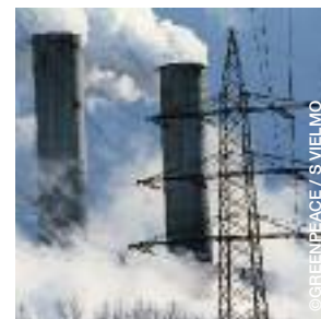
Central de lignito de RWE, en Frimmersdorf, la central térmica de carbón alemana más contaminante.
