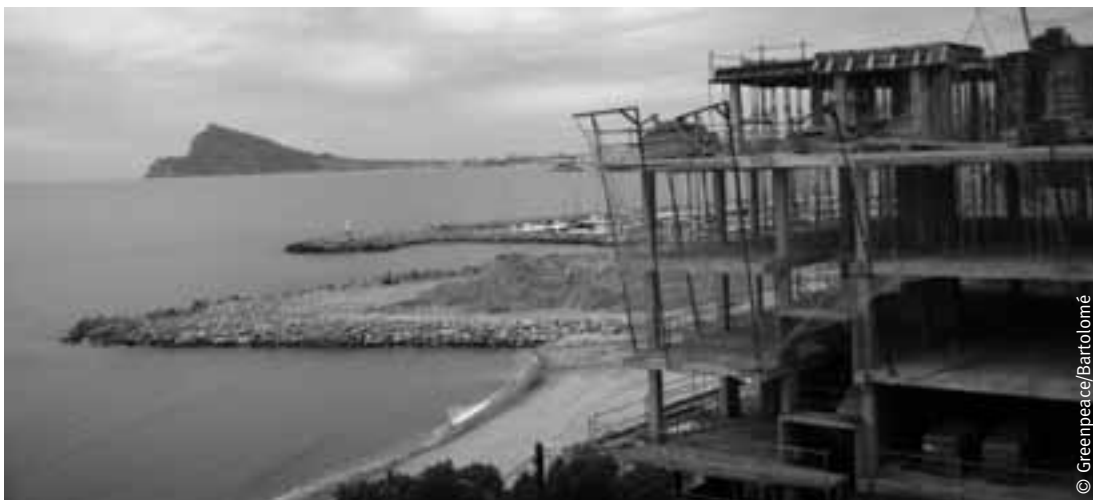
Construcció d'edificis al costat del port esportiu Lluís Campomanes a Altea, Alacant.
