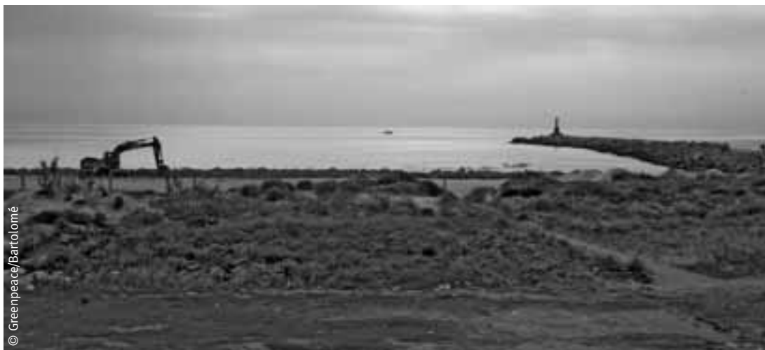
Una màquina treballant sobre la sorra en Platja Escullera, Cullera (València).
