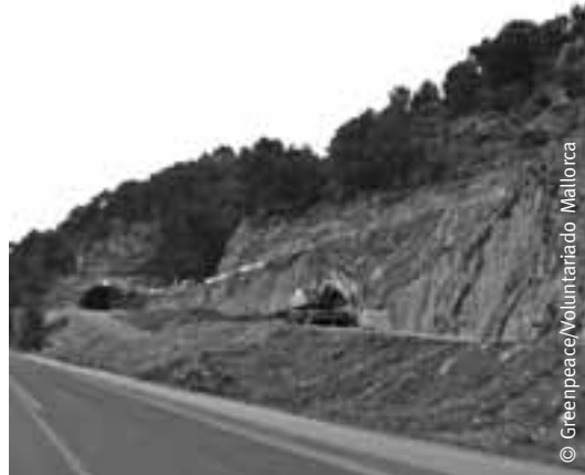
Obres de construcció del túnel per al nou accés al Port de Sóller (Mallorca).
