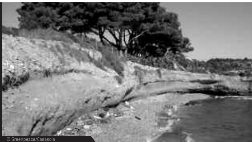
EROSIÓN COSTERA EN L'ATMELLA DE MAR, TARRAGONA
