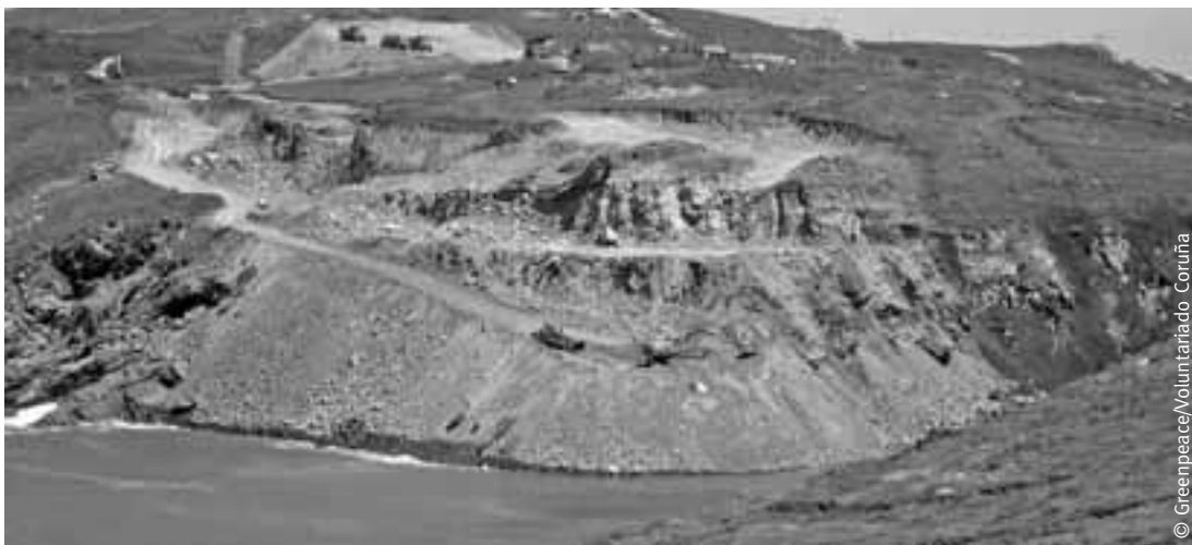
Obras de construción do Porto exterior da Coruña.
