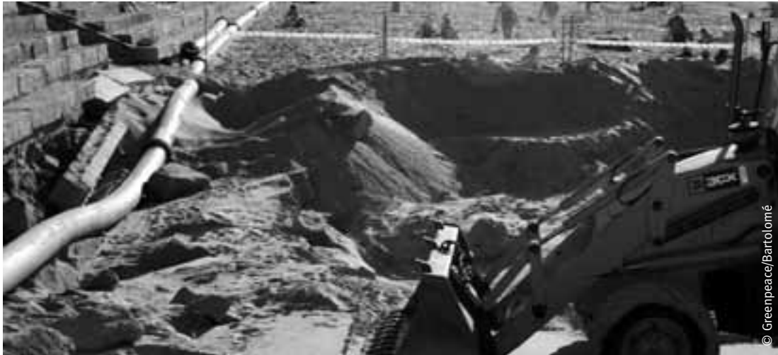
Maquinaria traballando na praia de Santa Cristina, A Coruña.
