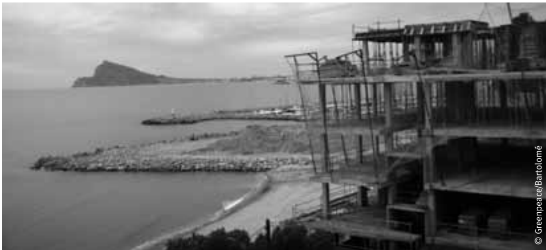
Construcción de edificios junto al puerto deportivo Luis Campomanes en Altea, Alicante.
