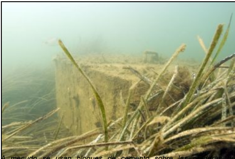
A menudo se usan bloques de cemento sobre las praderas de posidonia como anclaje para mantener las boyas de fondeo para las embarcaciones de recreo.
