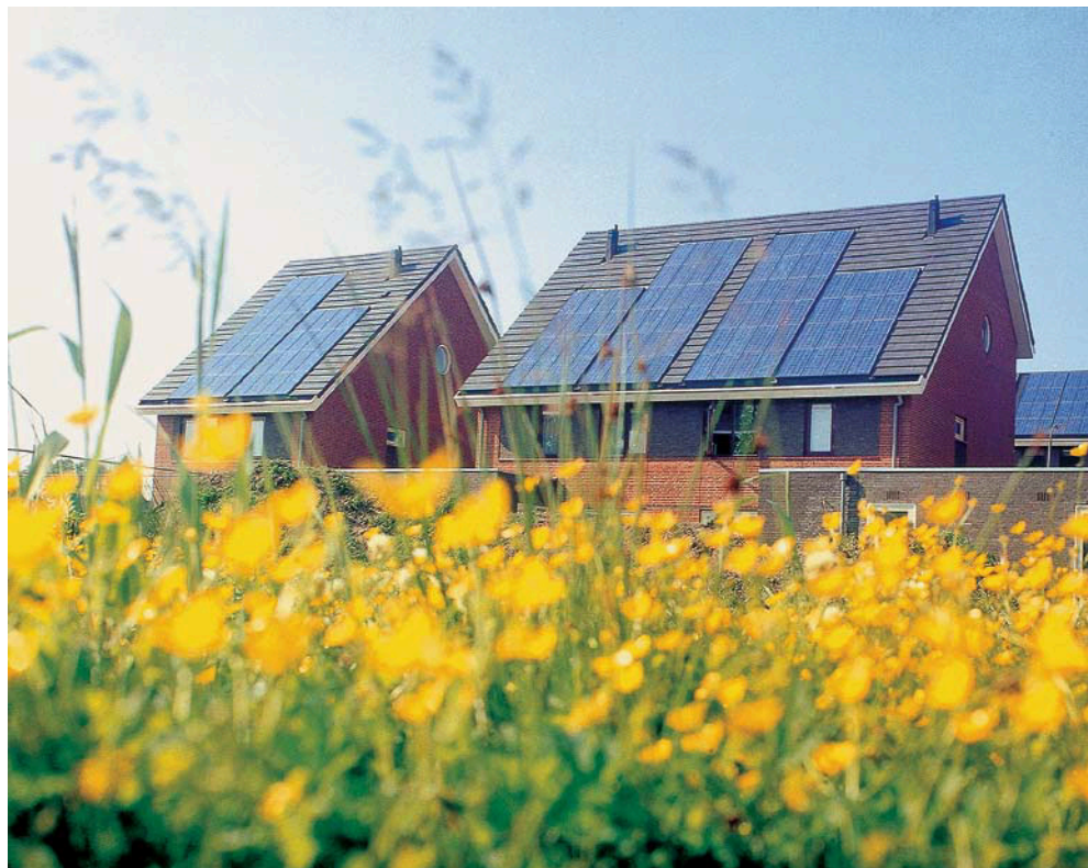
Solar house De Boegspriet (De Keen) in Etten-Leur
