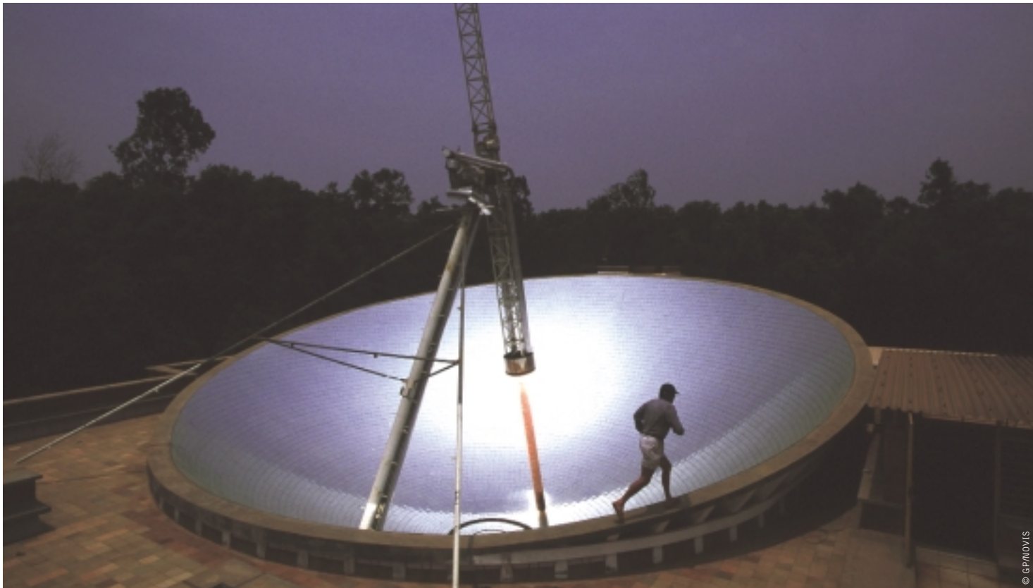
インド南部タミルナドゥ州オーロヴィルにあるソーラーキッチンに設置されている太陽熱集熱器。太陽光の熱で、一日2000人分の食事をまかなっている。オーロヴィルは世界の100あまりの国や地域から集まった人々が協働する実験型エコヴィレッジ。住民は環境再生、有機農業、代替エネルギー、村づくり、劇、音楽、芸術などの活動に従事している。
