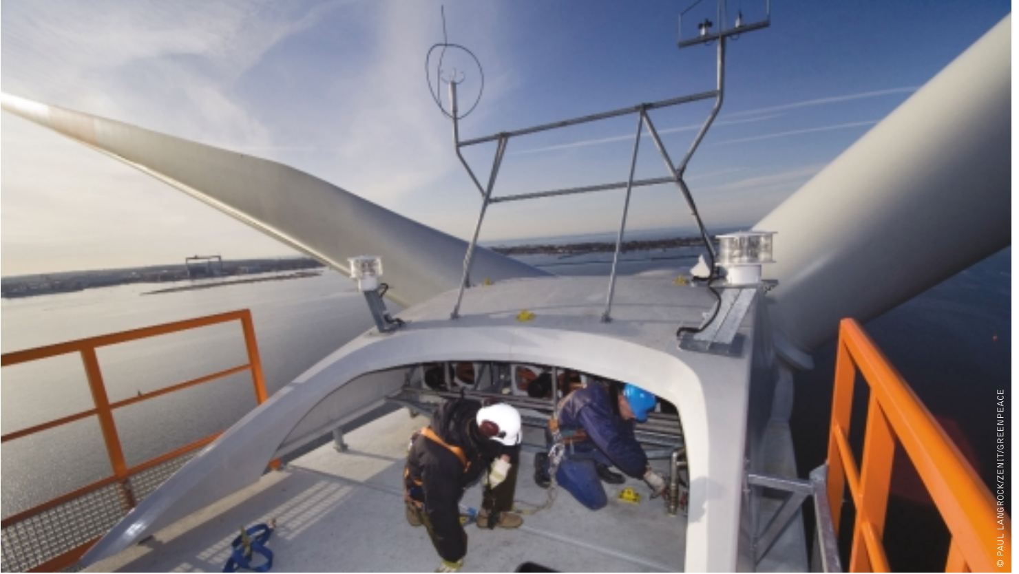
ドイツ北部ロストック港において、沖合い条件で試験運転中の独・ノルデックス社製風力発電機N90 2500。定格出力2.5メガワット。少なくとも10基の同型機が、2007年までにバルチック海の沖合20キロメートルの小島に設置される予定だ。
