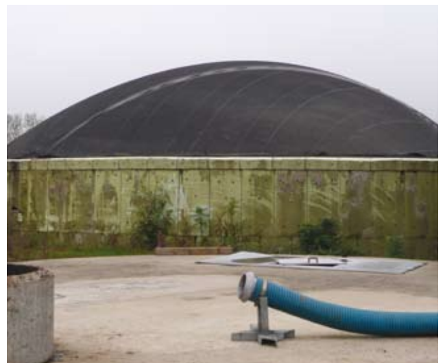
Die Biogasanlage Beckerichs mit dem Schlauch zur Einspeisung der Rohstoffe © Greenpeace / Daniela Pichler
