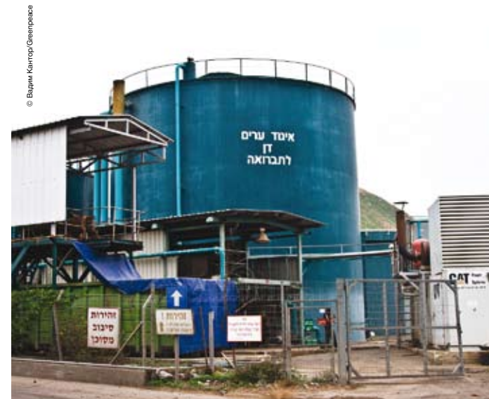
В этом баке бактерии вырабатывают из органических отходов метан.
