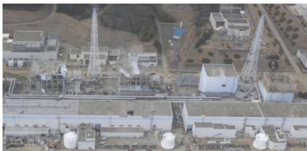
Sullo sfondo, l'unità 4 di Fukushima-Daiichi, in primo piano l'unità 3, parzialmente alimentata con MOX (miscela di ossidi di uranio e plutonio) della francese AREVA. © TEPCO
