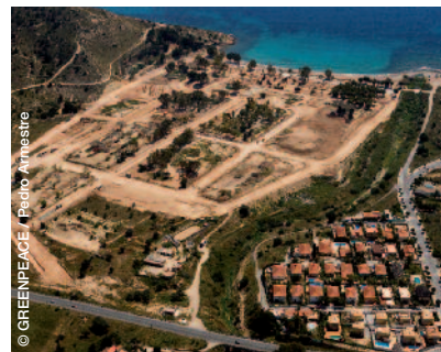
Obras en el frente litoral de Villajoyosa.
