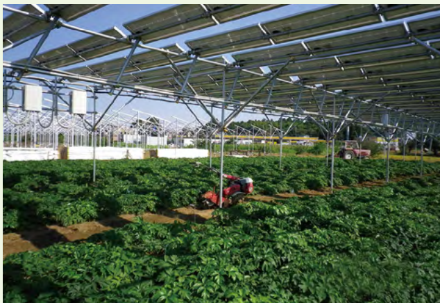
農地に太陽光パネルを設置し、農業と太陽光発電を並行して行う「営農型太陽光発電」。作物に加え、電力を売ることで農家にとって収入源が二重に。© ソーラーシェアリング協会
