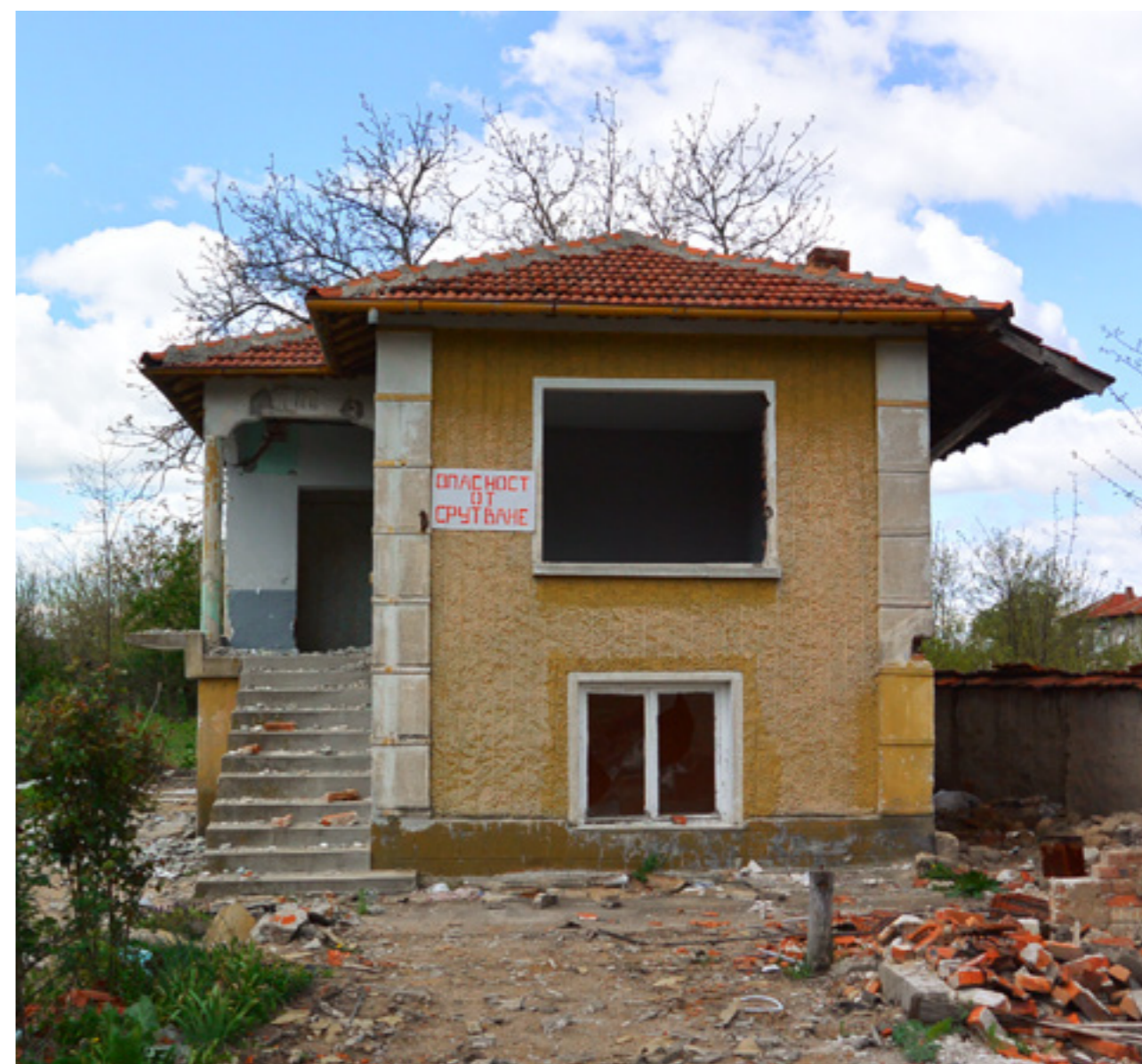
Снимка 1. Разрушена къща в с. Бели бряг
