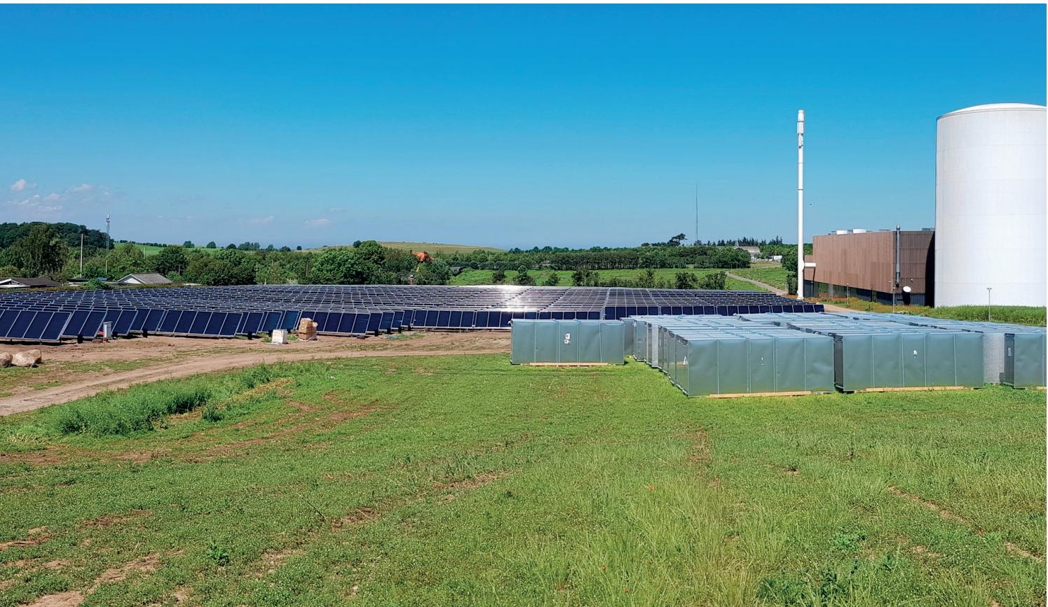
**Слънчева топлоцентрала в Корсор, Хейлсков (Korsør, Halskov), Южна Дания, с мощност 8 MW. Пусната е в експлоатация през лятото на 2019 г. Годишно ще произвежда 6500 MWh топлинна енергия и ще захранва 5000 домакинства в региона. Снимка: Aalborg CSP A/S**
