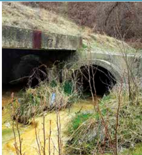
Фигура 6. Бетонен канал надолу по течението от долния изравнител, където се появява отново на повърхността, след като преминава под черен път, и бетонният канал по-надолу по течението на река Каменишка
