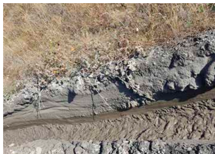
Фигура 10. Твърд материал, натрупан по страните на бетонния канал, използван за транспортиране на пепелна суспензия, близо до депото за съхранение на възлищни отпадъци „Каменик“
