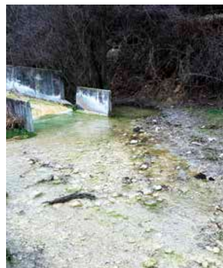
Фигура 7. Бетонният канал, който започва под долния изравнител и продължава по река Каменишка
