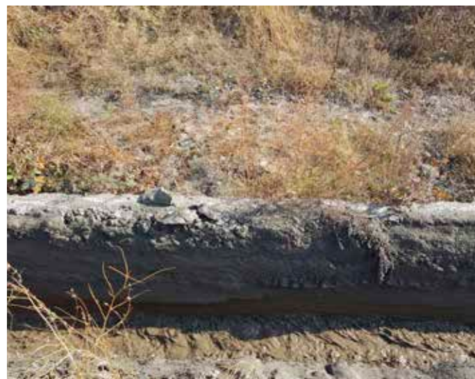
Фигура 10. Твърд материал, натрупан по страните на бетонния канал, използван за транспортиране на пепелна суспензия, близо до депото за съхранение на възлищни отпадъци „Каменик“
