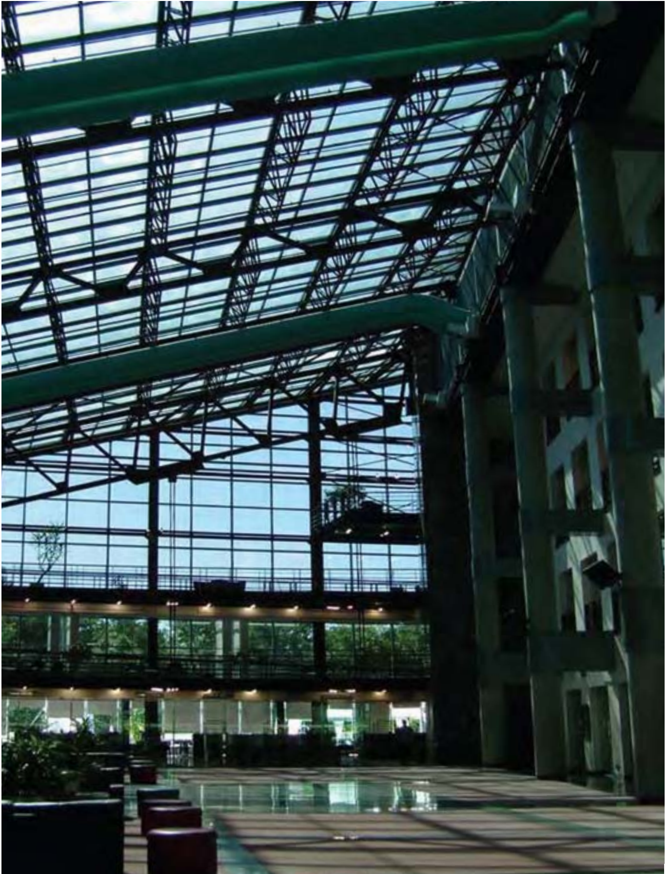
Bureaux de la CCSN à Télésat à Ottawa
