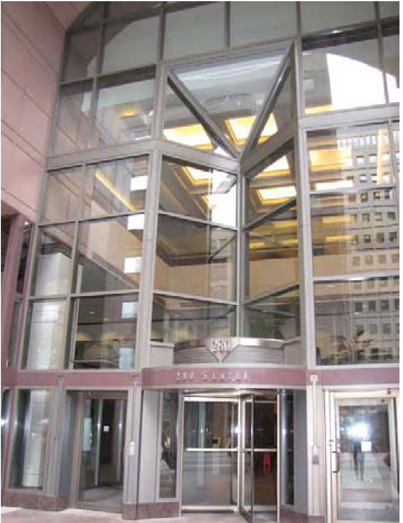
Bureaux de la CCSN au 280, rue Slater à Ottawa
