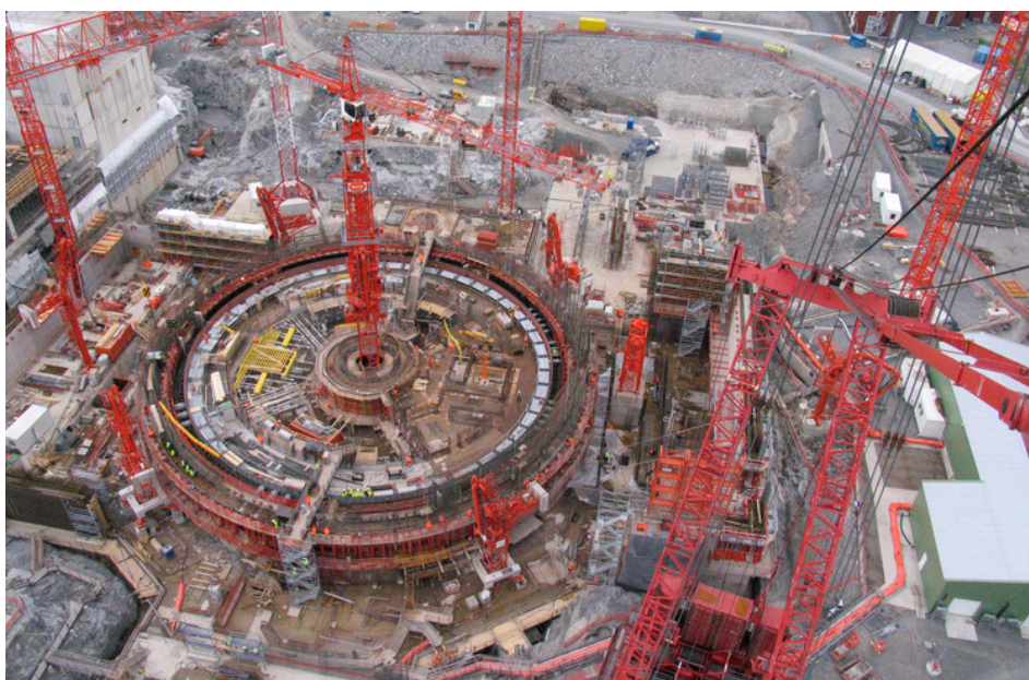
Billede 1 - Konstruktionen af Olkiluoto 3 i Finland i 2007. Anlægget blev færdigbygget i 2022 efter 13 års forsinkelse © Greenpeace / Nick Cobbing
