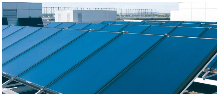
Εγκατάσταση ηλιακού κλιματισμού
