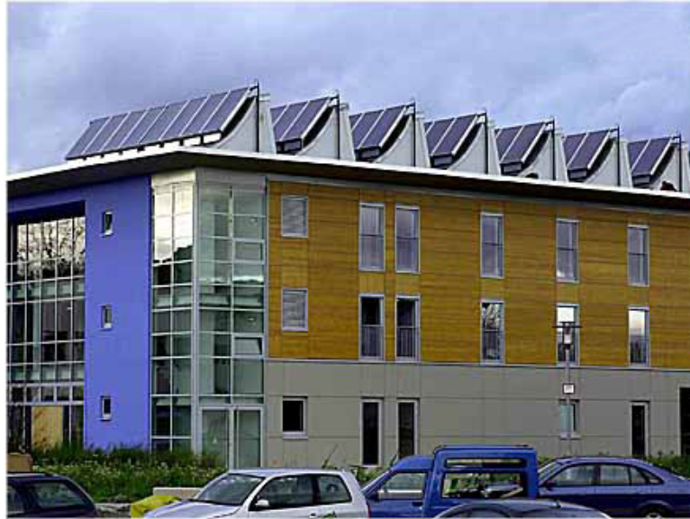
Ηλιακή θέρμανση κτιρίου γραφείων
