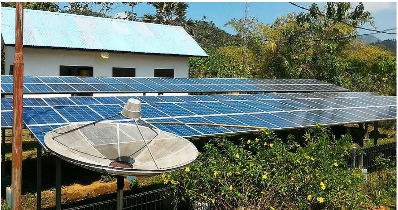
Gambar 15. PLTS off-grid untuk komunitas di daerah terpencil
