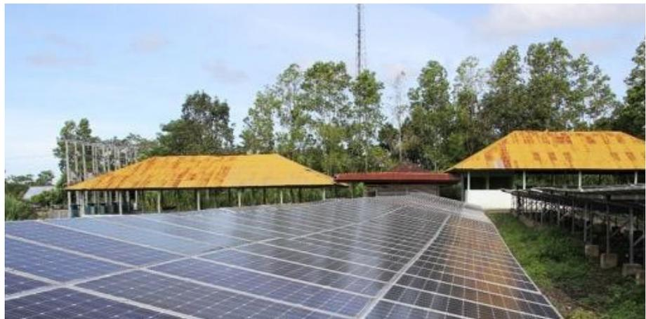
Gambar 16. PLTS *on-grid ground mount* di Desa Kayubihi kapasitas 1 MWp
