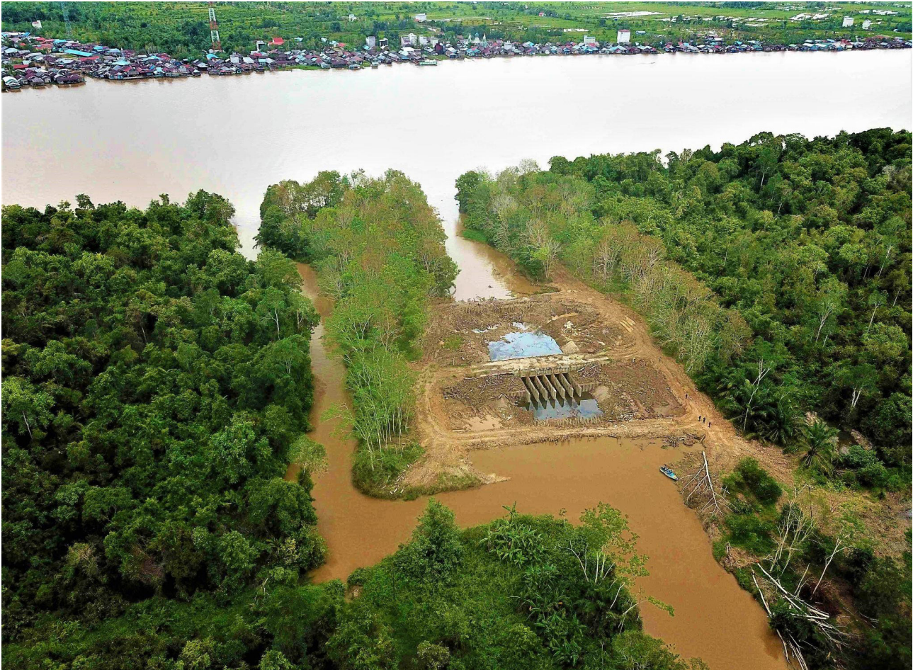
Pintu air yang tak berfungsi di Talekong Punai, ujung selatan bekas PLG Blok A. Ini merupakan salah satu titik di mana kanal drainase utama terhubung ke sungai-sungai utama, dalam hal ini Sungai Kapuas Murung (2°48'05.1"S 114°38'07.1"E), Greenpeace, 30 Juli 2022.
