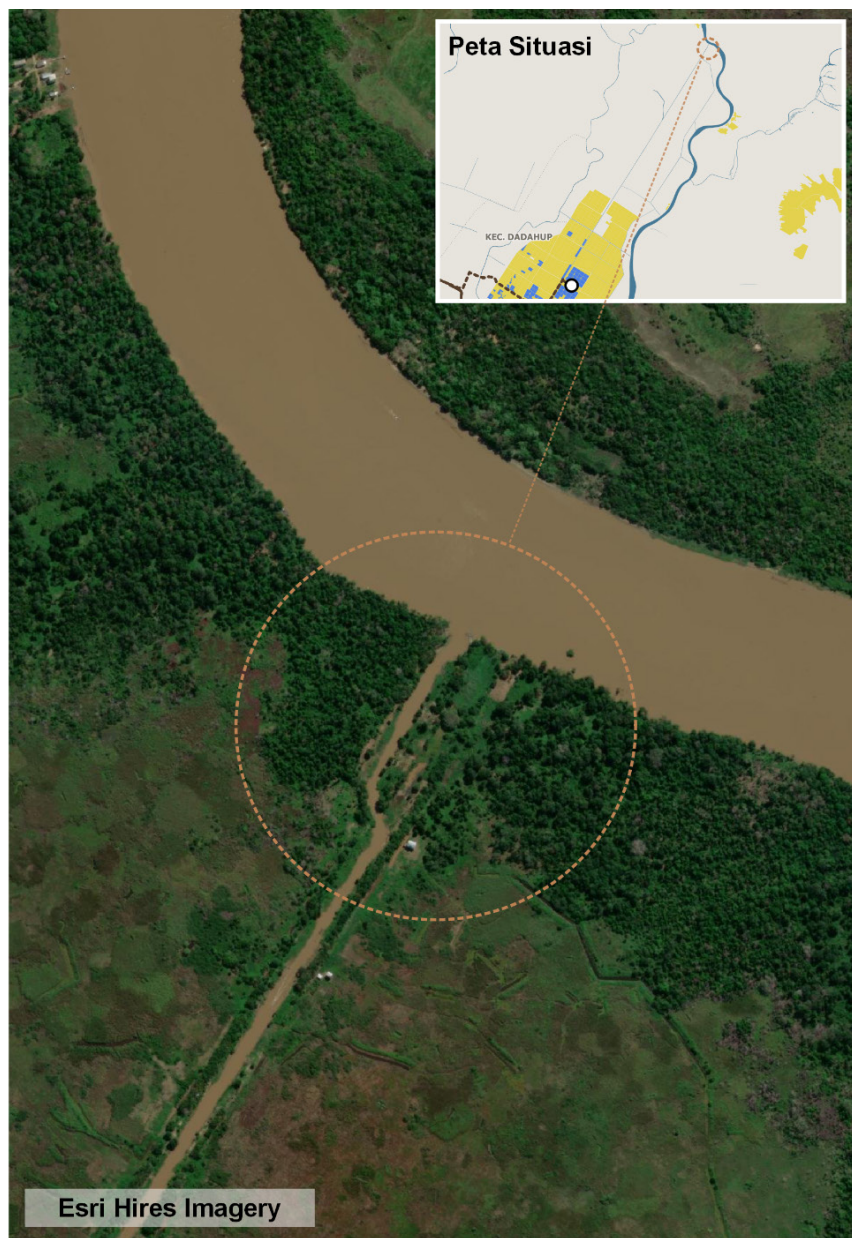
Citra satelit: Kanal drainase lahan gambut melintasi Kecamatan Dadahup, tanpa pintu air yang berfungsi yang dapat mengatur drainase dan banjir. (2°21'16.54"S 114°53'11.99"E)
