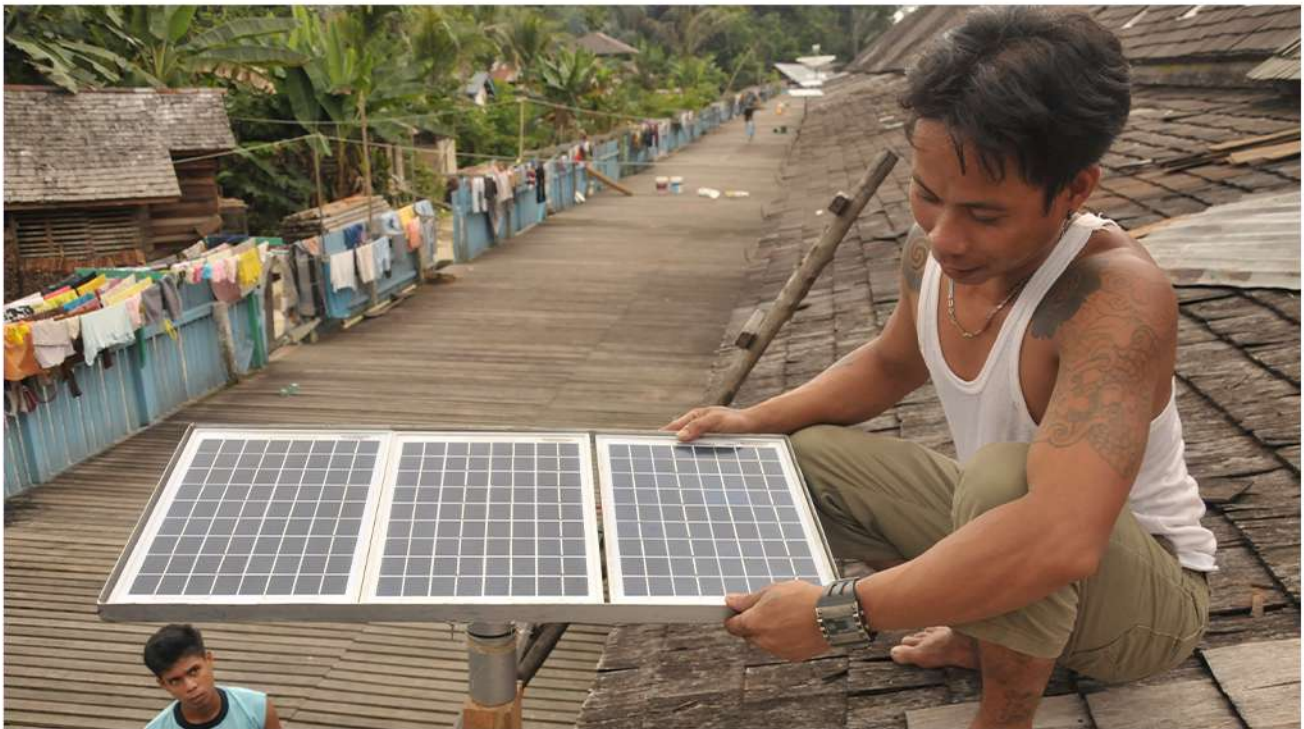
© Enter Indonesia/Greenpeace. Memasang panel tenaga surya di rumah panjang bersama. Di area tempat tinggal Sungai Utik tidak terdapat akses listrik.
