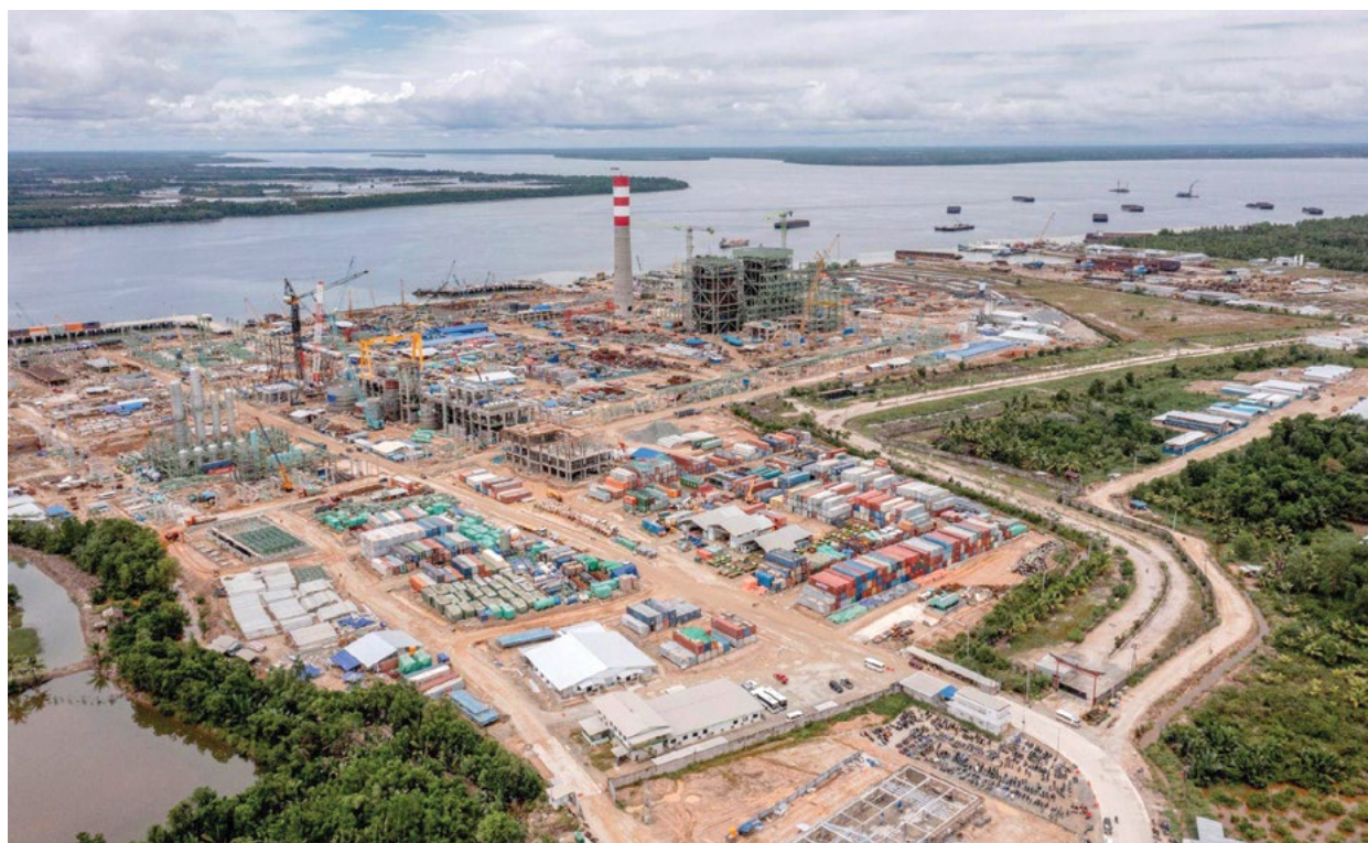
Pembangunan pabrik pulp Tarakan, Kalimantan Utara oleh PT Phoenix Resources International bulan Februari 2024.
