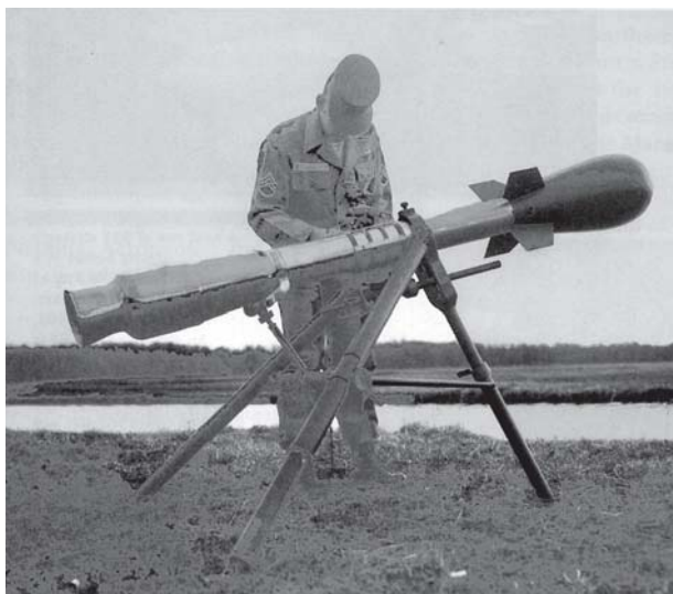
Fig. 10 - Una delle più piccole bombe nucleari tattiche mai realizzata, la Davy Crockett. Peso circa 23 kg; potenza circa 20 tonnellate di tritolo equivalente (un millesimo rispetto a Hiroshima)
