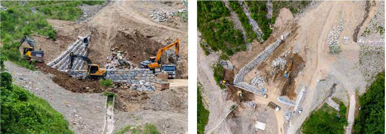
▲ [그림 17] 곤돌라를 타고 올라가며 확인된 사방댐 및 배수로 건설 현장
