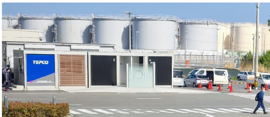
L'arrivée sur site, avec quelques unes des 1000 cuves où sont stockés les millions de m 3 d'eau contaminée.
