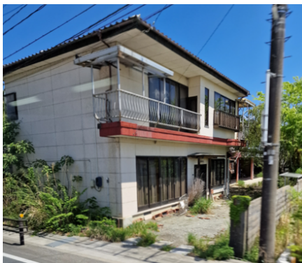
L'une des maisons abandonnées sur la route vers le site de Fukushima Daiichi.
