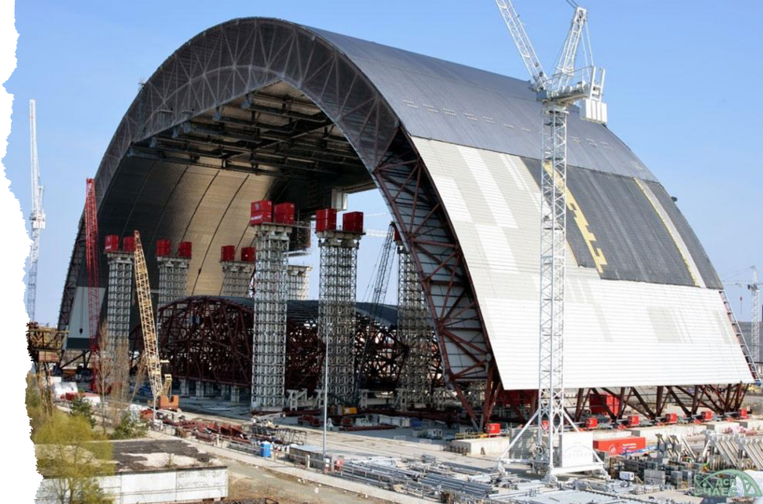
Abbildung 3: Tragwerk des NSC und innere/äußere Schalen während der Bauphase Quelle: Staatliche Nuklearaufsichtsbehörde der Ukraine.
