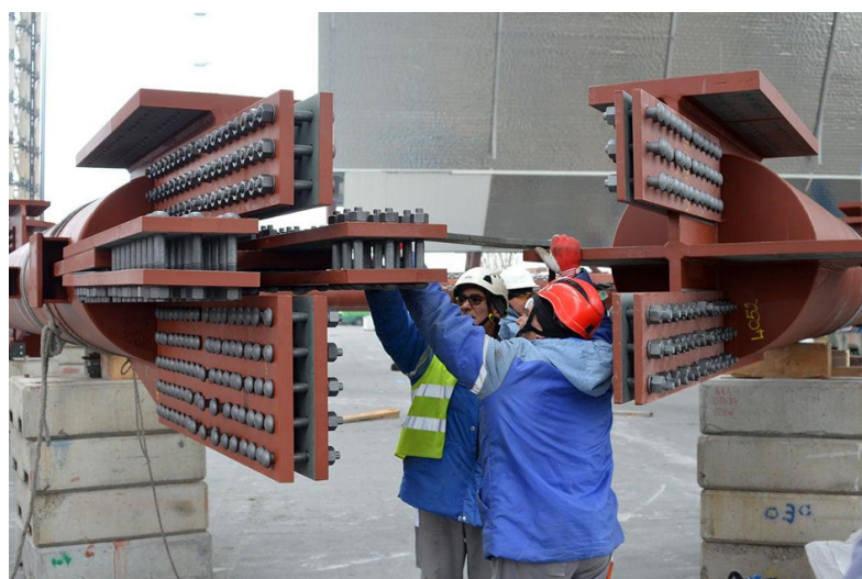
Abbildung 4: NSC-Rohre, -Platten und -Schrauben während des Baus Quelle: Staatliche Nuklearaufsichtsbehörde der Ukraine.
