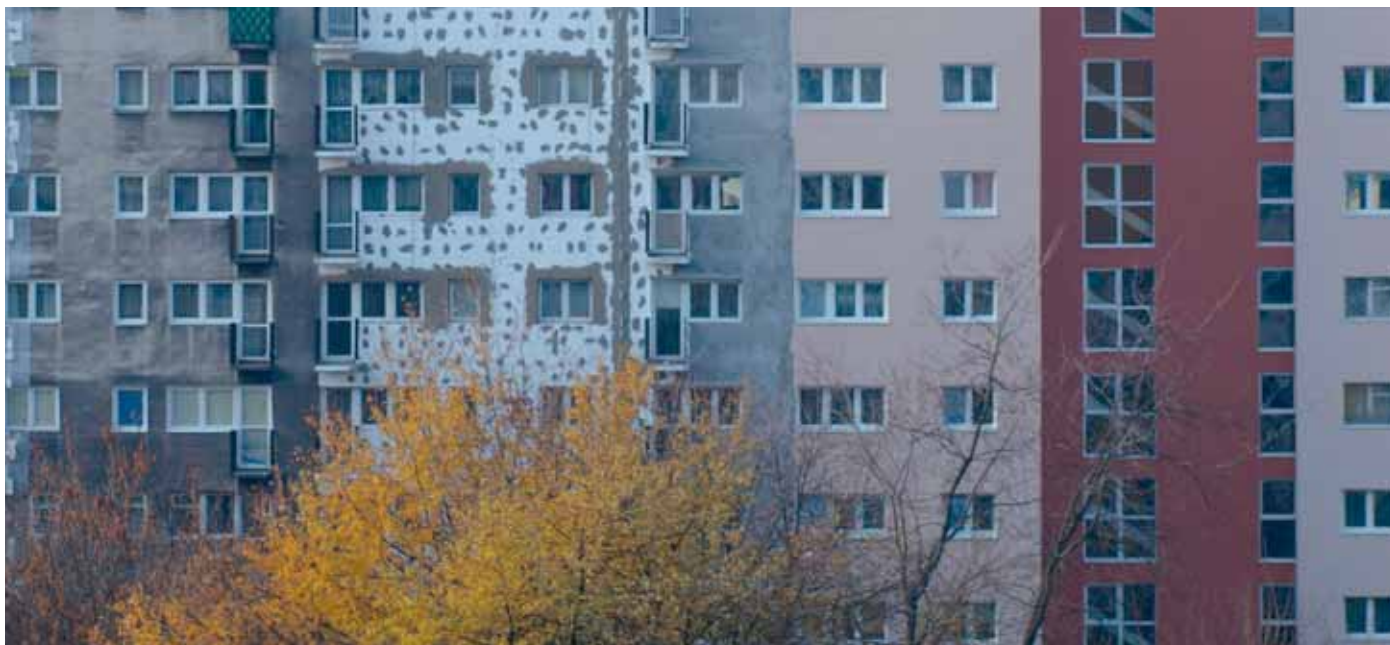
Prace przy termomodernizacji (ocieplaniu) budynku mieszkalnego. Fot. z archiwum Biura Infrastruktury
