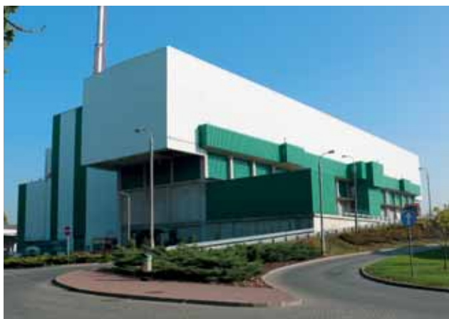
Zakład Unieszkodliwiania Stałych Odpadów Komunalnych. Fot. z archiwum ZUSOK
