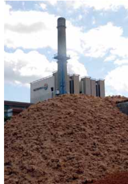
Magazyn biomasy w Elektrociepłowni Żerań. Fot. z archiwum Vattenfall
