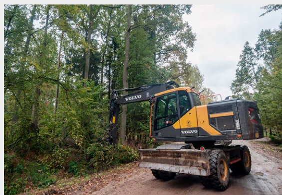
Fot. 13. Rozbudowa Drogi Narewowskiej. Jesień 2017.
