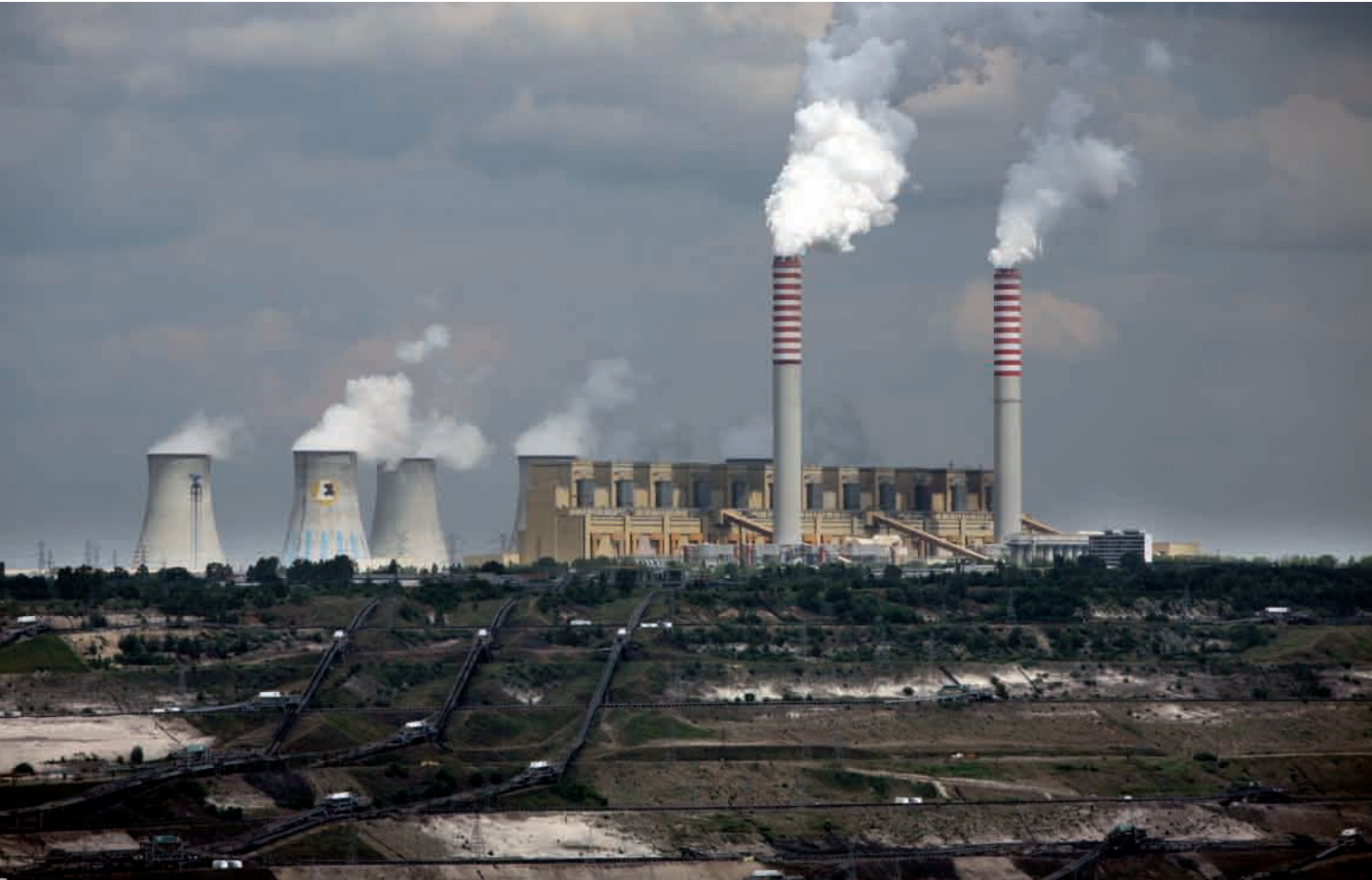
Elektrownia BOT Bełchatów o mocy 4400 MW, spalająca węgiel brunatny; emituje 30 mln ton CO 2 rocznie (tyle, co Słowenia i Estonia razem)
