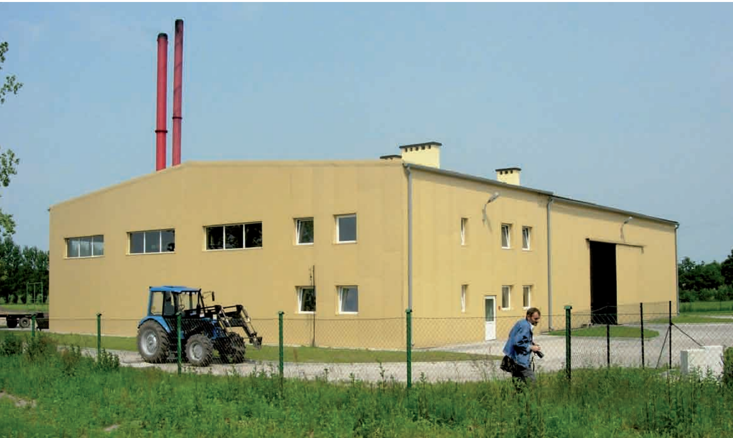
Kotłownia opalana biomasa o mocy 3 MW, Kisielice, woj. warmińsko-mazurskie
