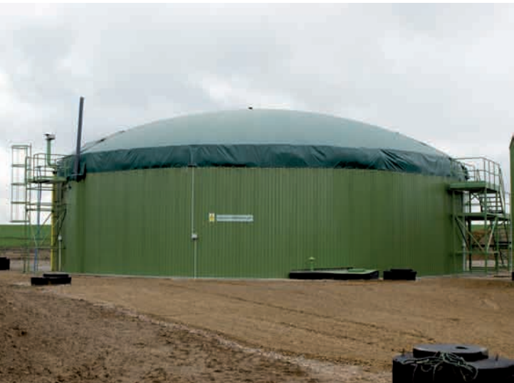
Biogazownia o mocy 625 kW w Płaszczycy, woj. Pomorskie, gmina Przechlewo
