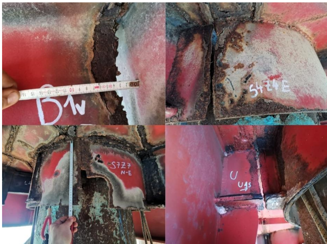
Platforma OMV Petrom aflată într-o stare avansată de degradare
