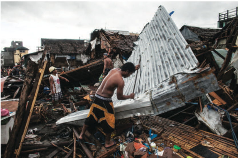
คนงานกำลังซ่อมแซมอาคารที่เสียหายจาก พายุไต้ฝุ่นคัมมูรี ที่นครเลกซ์ปี ในจังหวัดอัลโบของฟิลิปปินส์
