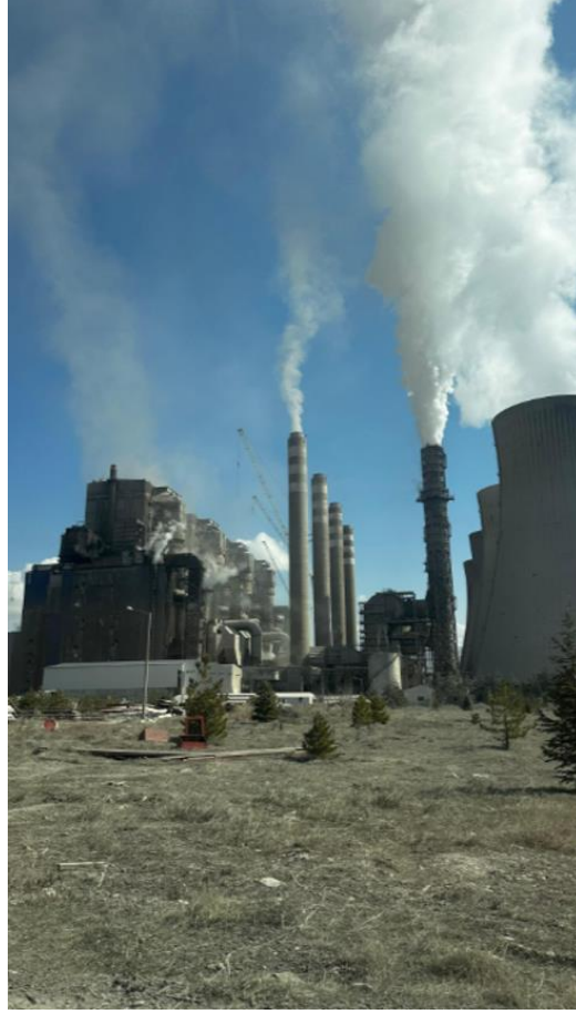
Fotoğraf 1: Çelikler Afşin Elbistan (A) Termik Santrali genel saha görünümü (Çekim Tarihi: 13.03.2026, Saat: 11:09). Görüntüde 4. Üniteye ait iki baca açıkça seçilmektedir: ön bacadan çıkan duman FGD sisteminden geçirilmiş arıtılmış baca gazını, arka bacadan çıkan duman ise baca gazı arıtma sistemini bypass ederek doğrudan atmosfere verilen kirli gazı temsil etmektedir. I., II. ve III. Ünitelere ait bacalardan duman çıkışı gözlemlenmemekte olup bu durum söz konusu ünitelerin ölçüm tarihi itibarıyla faaliyette bulunmadığına işaret etmektedir.
