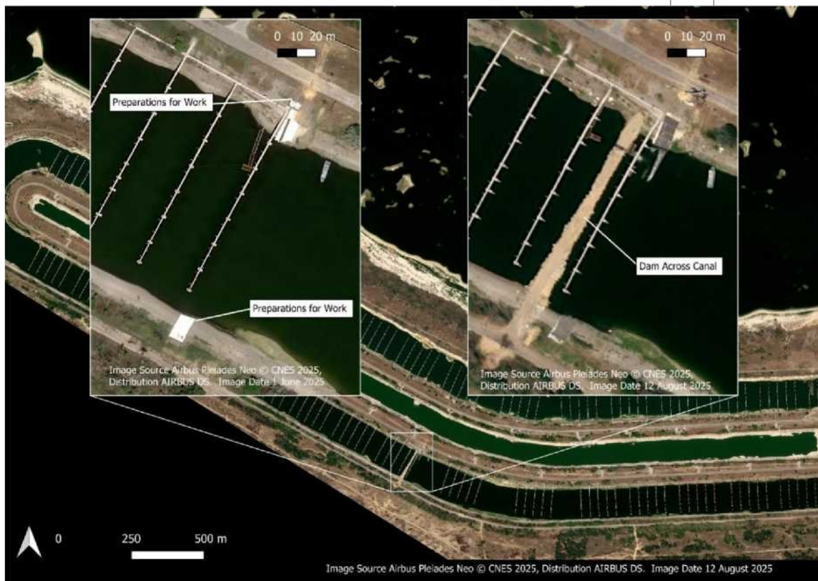
Рис. 3 – Будівництво греблі в каналі водозабору
