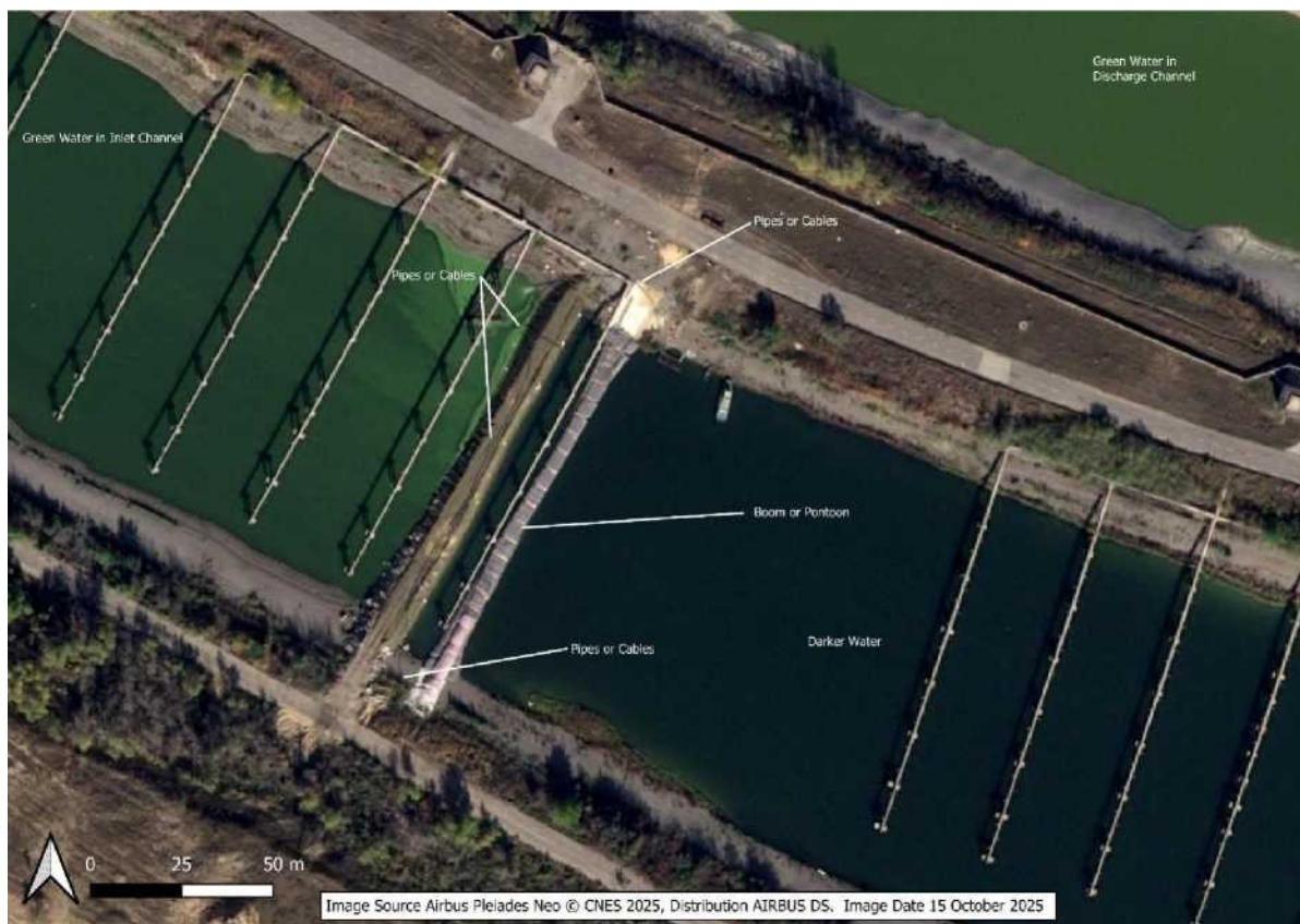
Рис. 4 – Бонове загородження або понтон у каналі водозабору
