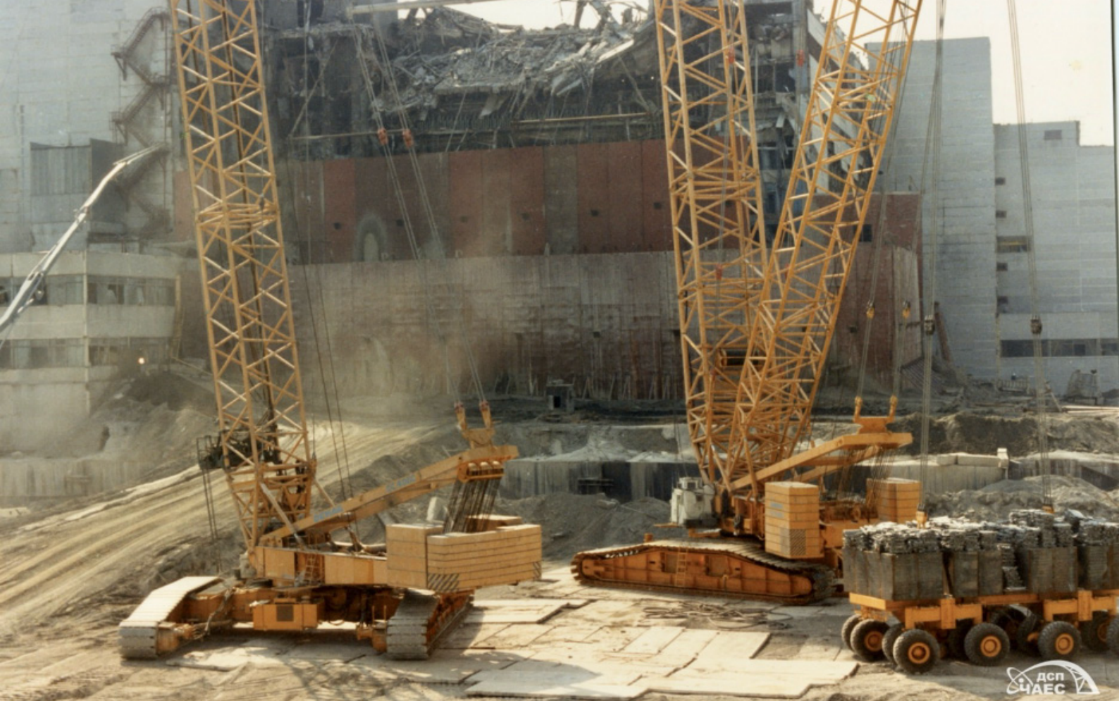
Крани Детаг під час будівництва укриття у 1986 році – фото ЧАЕС
