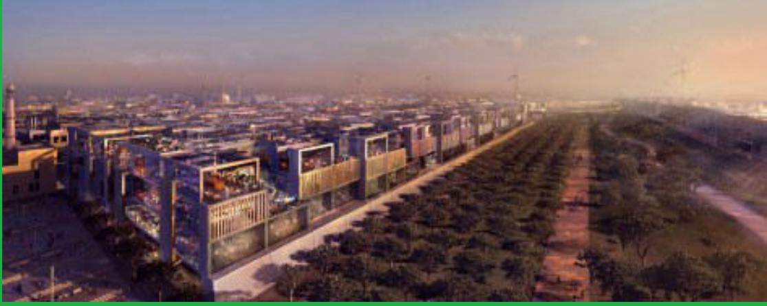
تُعدّ مدينة مصدر مدينةً خضراء ولا تصدر عنها أي انبعاثات (مصدر: TranssolarEnergietechnik GmbH)
